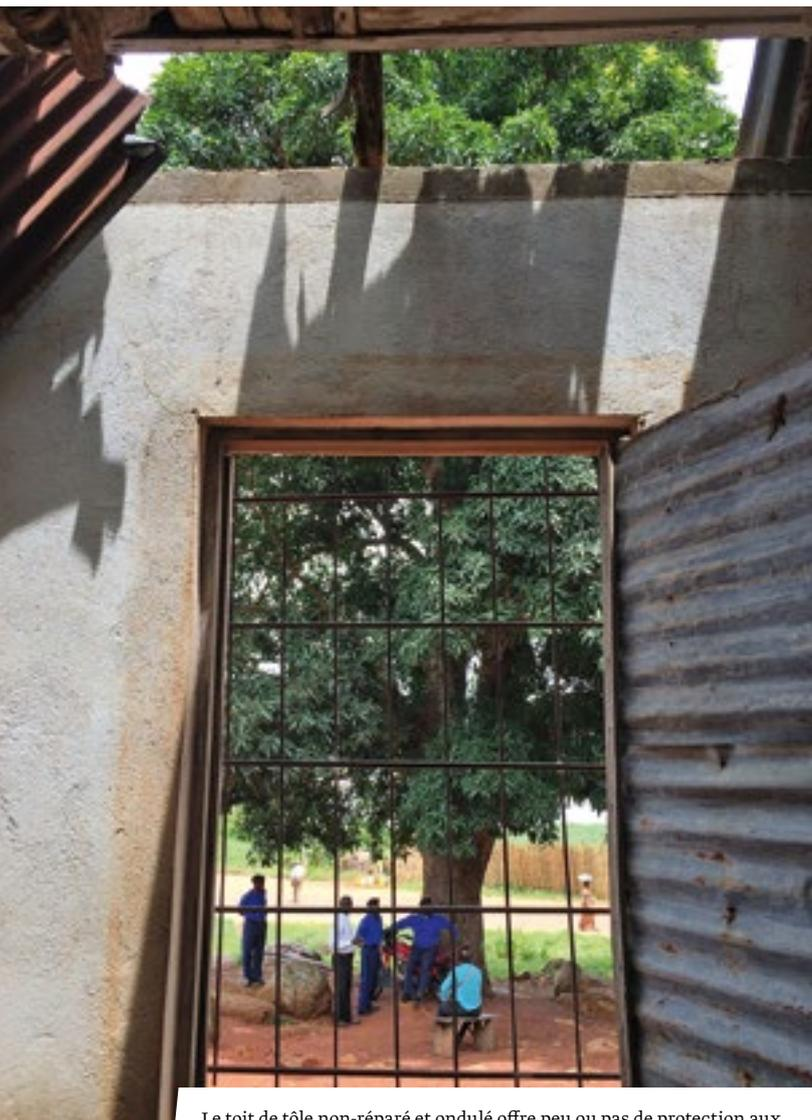
Le toit de tôle non-réparé et ondulé offre peu ou pas de protection aux armes et munitions face aux vols et aux aléas climatiques.
