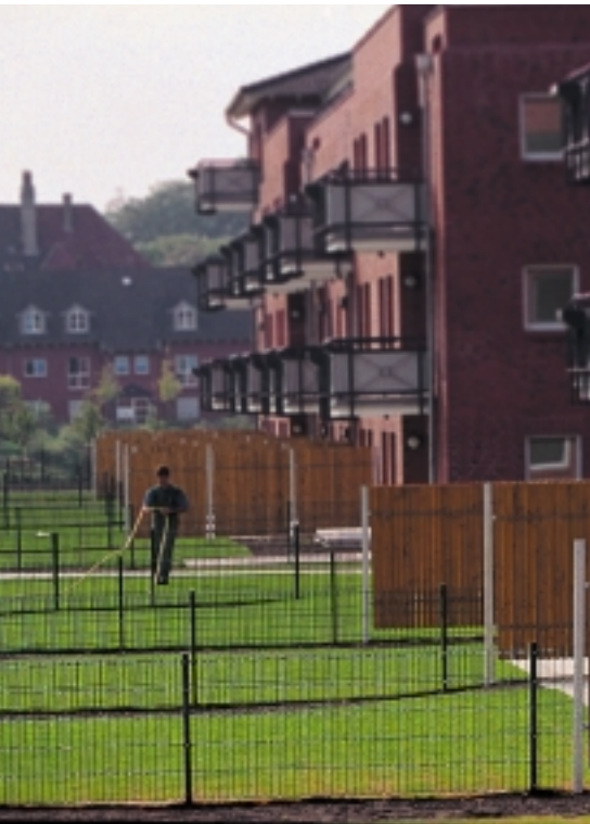
Umgebaute ehemalige Mannschaftsunterkünfte der Winkelmann-Kaserne
